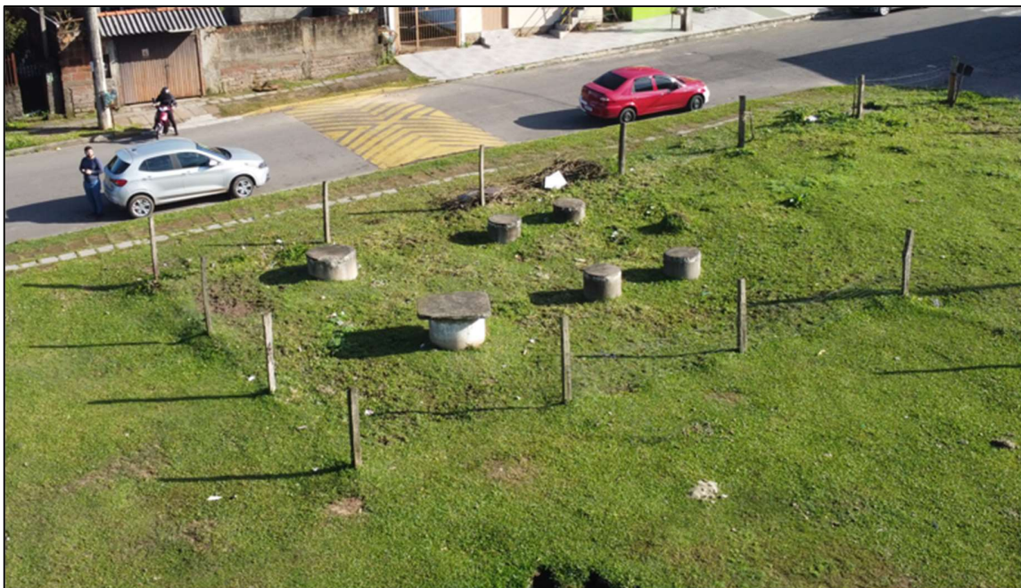
Figura 26: Sistemas fossa-filtro existente. Fonte: Araricá Saneamento Ltda.
