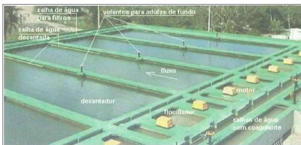
**Figura 18 – Flocculador mecanizado**
