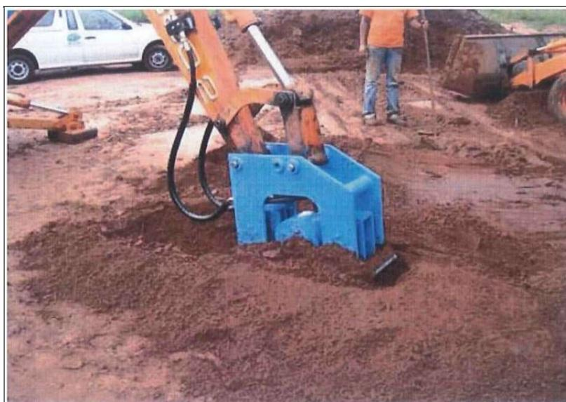
**Figura 7 - Início da compactação do reaterro da vala, utilizando o equipamento**
