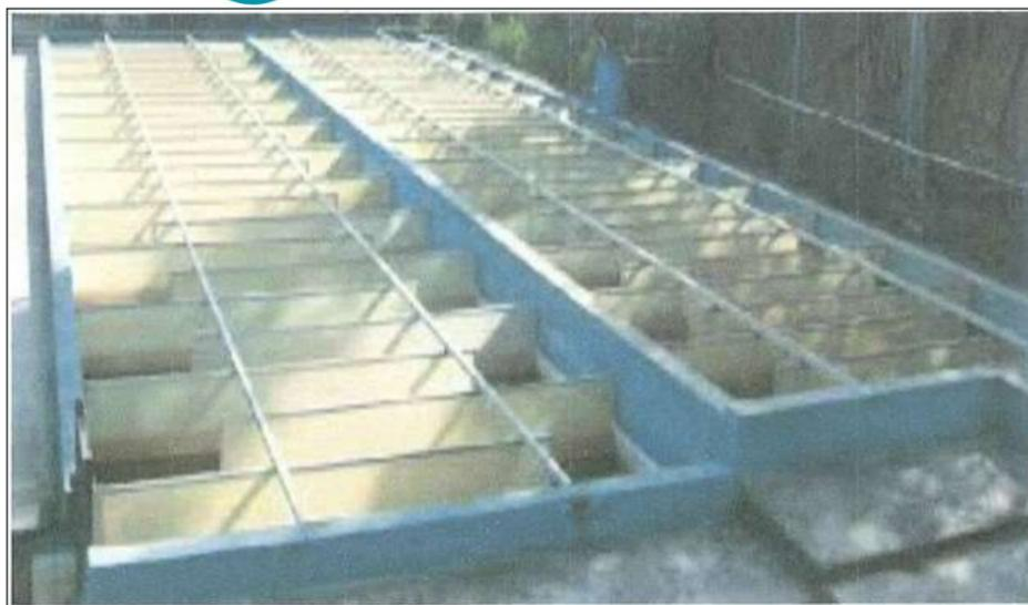
**Figura 17 – Flocculador hidráulico (fluxo vertical) em chicana**
