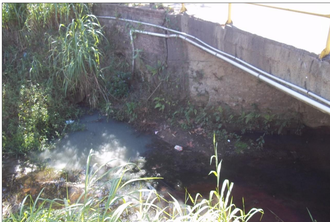
Figura 17: Ponto de contaminação cloacal em Araricá. Fonte: Keyassociados, 2016.
