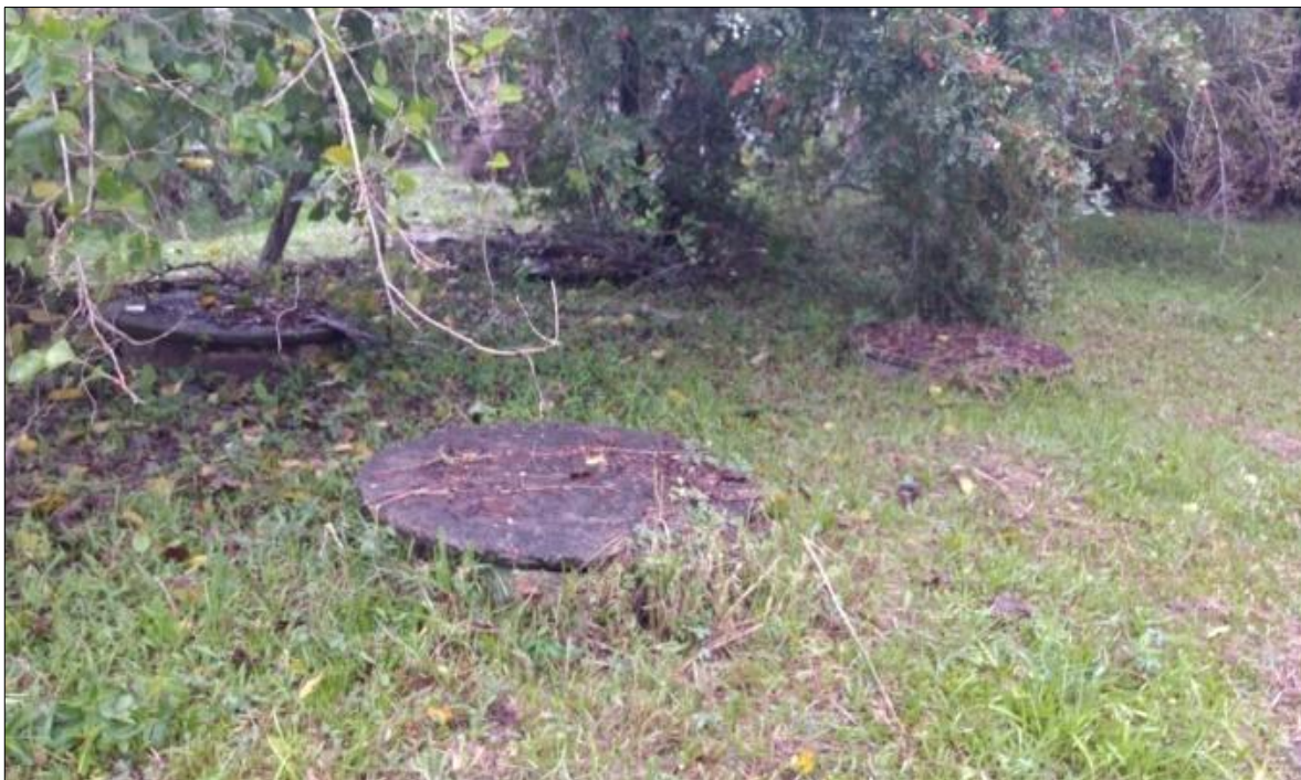
Figura 14: ETE Bairro Estação Fonte: Keyassociados, 2017.
