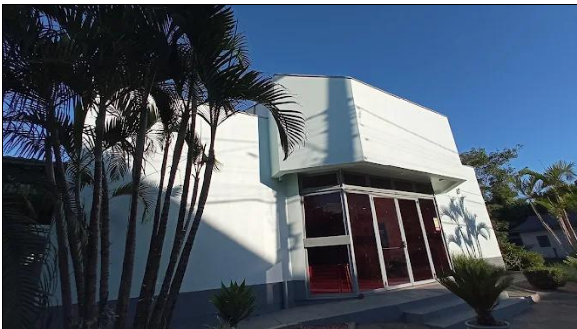
Figura 10 – Centro Cultural de Araricá.
