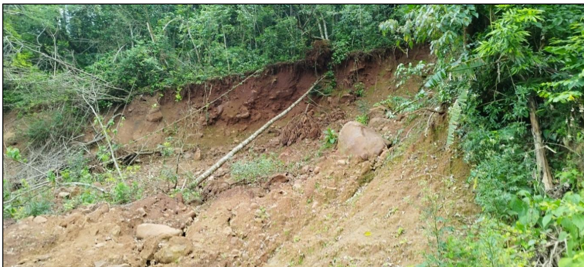
Figura 30 - Deslizamento encontrado dentro da ARIE do Morro Ferrabraz - Araricá.
